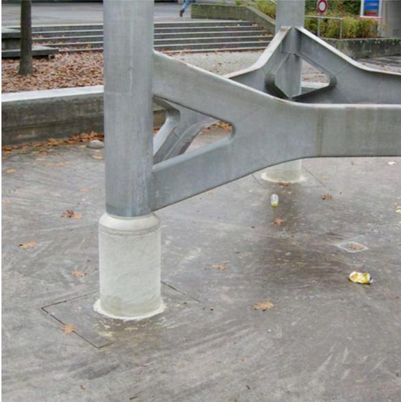
Der Stützenfuss wurde im Jahre 2001 wegen Korrosion saniert (Wermuth E., 2004). Dabei wurden die drei Stahlsäulen im Fussbereich neu grundiert und bis auf eine Höhe von ungefähr 60 Zentimetern wasserdicht ummantelt und beschichtet (Planzeichnung – Original bei TIAG).
