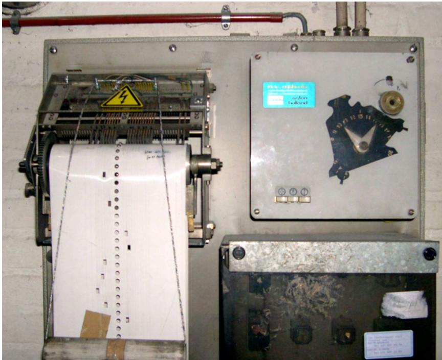
Steuerung des Glockenspiels mit Lochbandlauf (links), Zeitschaltuhr (oben rechts) und Sicherungskasten (unten rechts).
